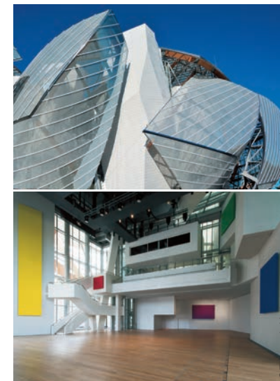
부풀어 오른 듯한 표피 내부에는 섬유 강화 콘크리트로 시공된 별도의 내부 공간이 존재한다.
